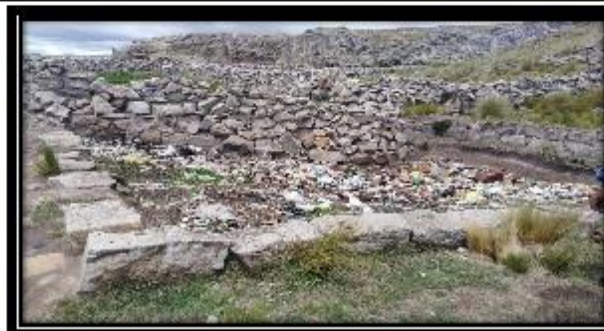
FOTO N° 11 INADECUADO CONSTRUCCION DE BOTADERO TARUCUYO
