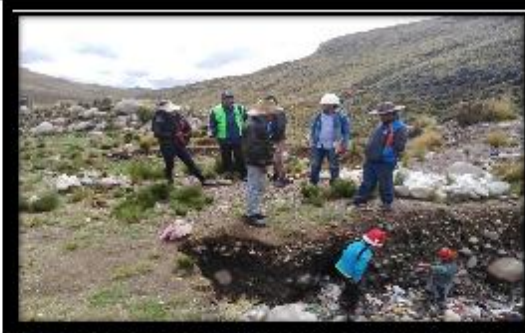
FOTO N° 13 FALTA DE CERCO PERIMETRICO DE PROTECCION DE BOTADERO
