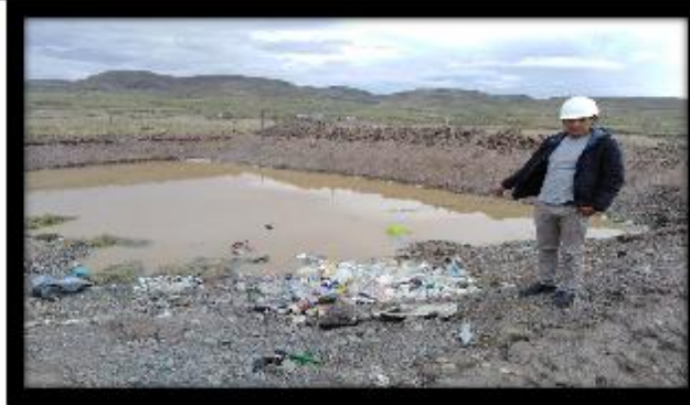
FOTO N° 07 FALTA DE DRENAJE EN RELLENOS SANITARIO HUAYHUAHUASI
