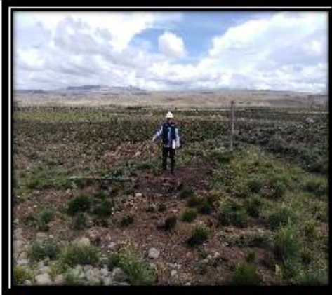
FOTO N° 06 FALTA DE CERCO PERIMETRICO RELLENO SANITARIO QUEROCCOLLANA
