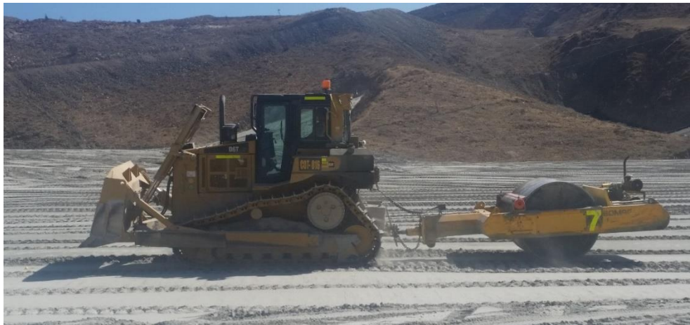
Figura 20. Proceso de compactación con Rola.
