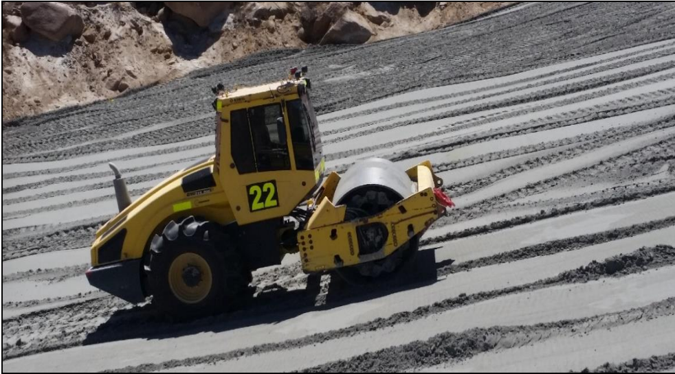
Figura 7. Rodillo Bomag BW 213 Fuente: Elaboración propia
