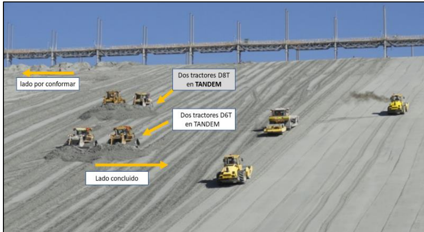
Figura 18. Conformación de relaves con el método tándem Fuente: Informe de producción del área de conformación y compactación.
