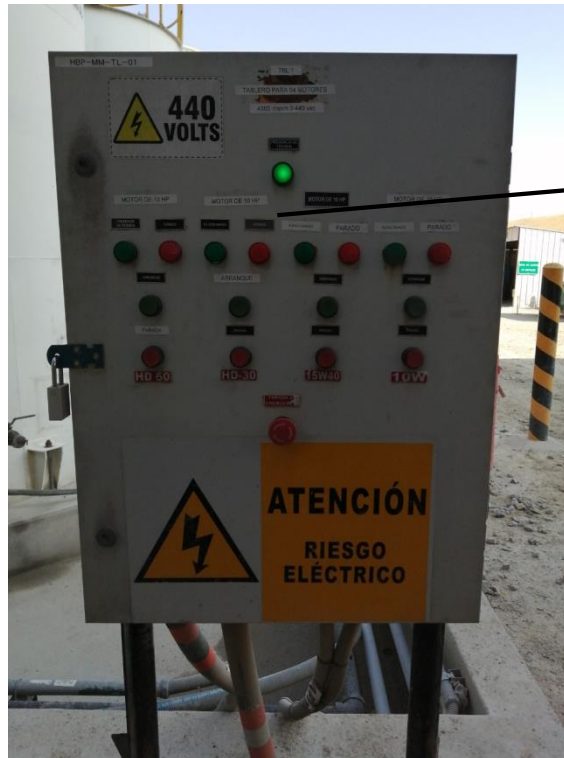
Figura 4. Tablero eléctrico de accionamiento de motores y bombas de lubricación. Tomado de: Diagnóstico del área de mantenimiento Unidad Minera Constanca
