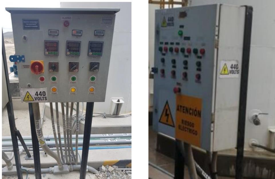
Figura 54. Mantenimiento del equipo eléctrico actual
