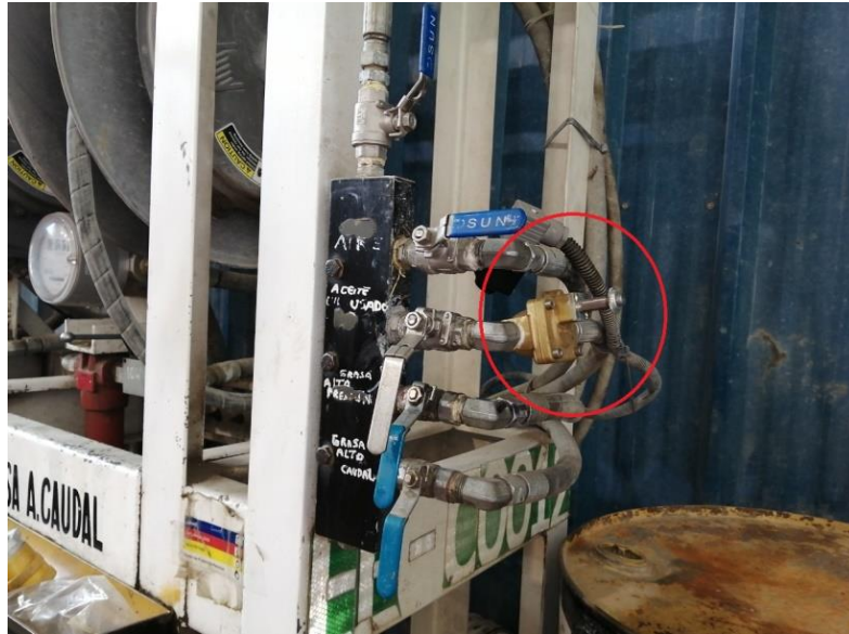
Figura 40. Válvula solenoide. Tomado de: Manual de mantenimiento. Unidad Minera Constancia (18)
