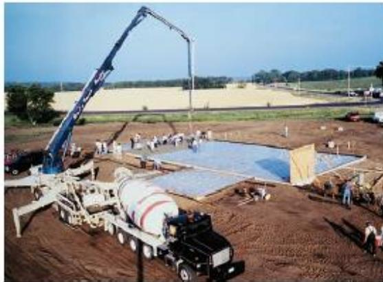
**Figura 40. Mixer de premezclado. Tomada de Portland Cement Association**
