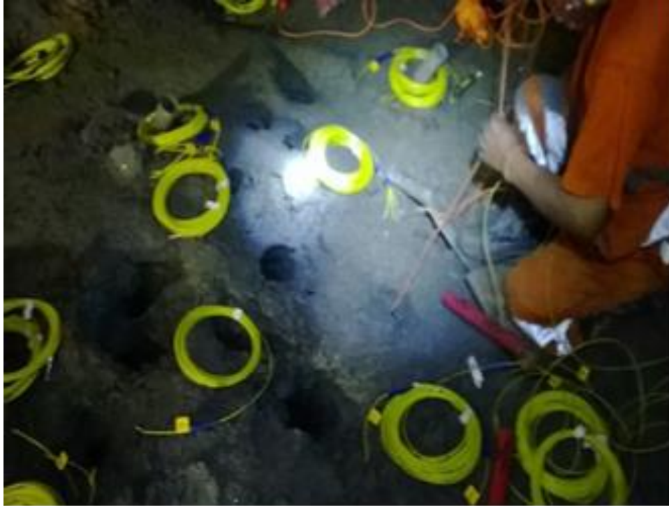
Figura 33. Carguío de taladros con el explosivo Emulnor 3000 y 1000
