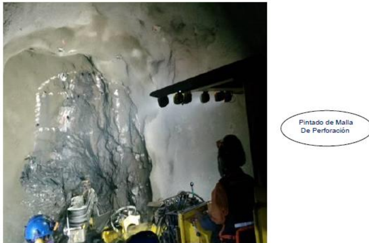
Figura 16. Capacitación en el campo sobre perforación Tomado del Departamento de Planeamiento de la unidad minera Carahuacra, Yauli 2019
