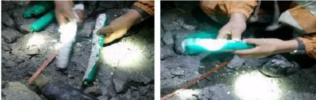
Figura 15. Deficiencias durante el carguío del explosivo Emulnor de 3000 Tomado del Departamento de Planeamiento de la unidad minera Carahuacra, Yauli 2019
