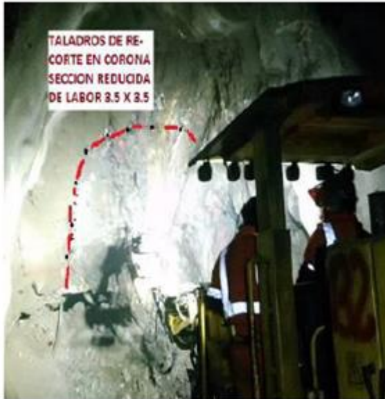
Implementación de Malla Perforación.
