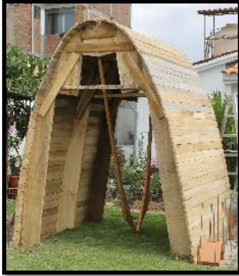
Fotografía 20: Encofrado para la bóveda catenaria
