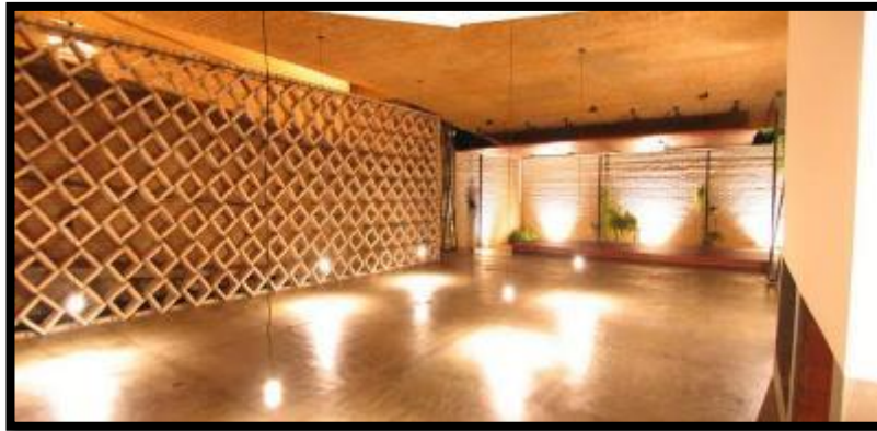
Figura 18: Muro interior de ladrillo "CASA ABU Y FONT"
