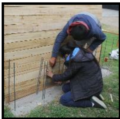
Fotografía 21: Trazado para la ubicación de módulos triangulares
