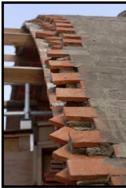
Figura 45: Capas de la bóveda de Crossway Home
