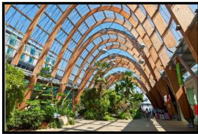
Figura 37: Vista interior del “JARDÍN DE INVIERNO DE SHEFFIELD”
