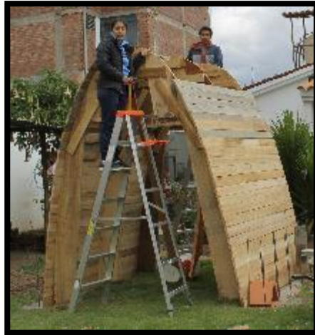
Fotografía 19: Finalización del entablado del encofrado
