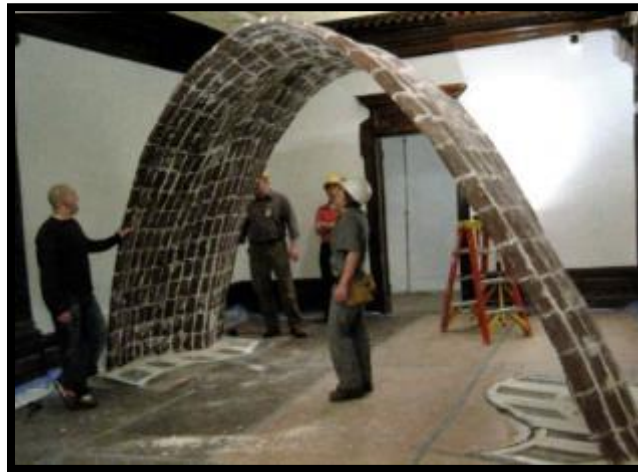
Figura 44: Vista final del prototipo de bóveda catenaria de ladrillo
