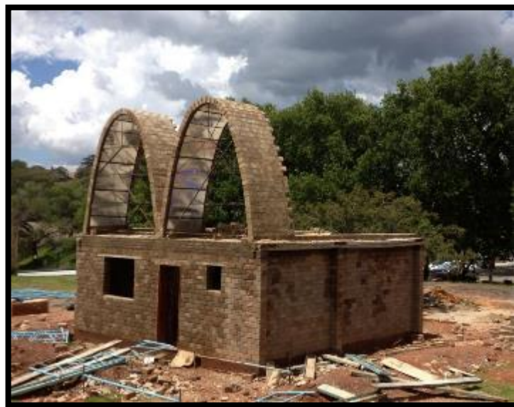
Figura 19: Proceso constructivo de bóvedas catenarias
