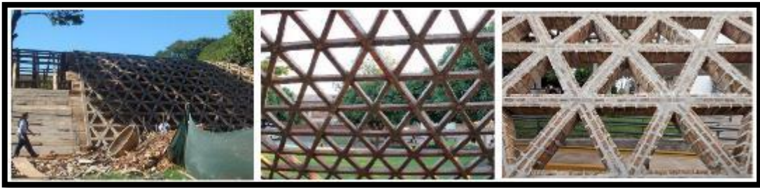
Figura 15: Proceso constructivo de la bóveda exterior
