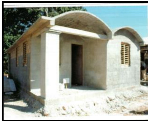
Figura 4: Vista de una vivienda con cobertura de bóveda
