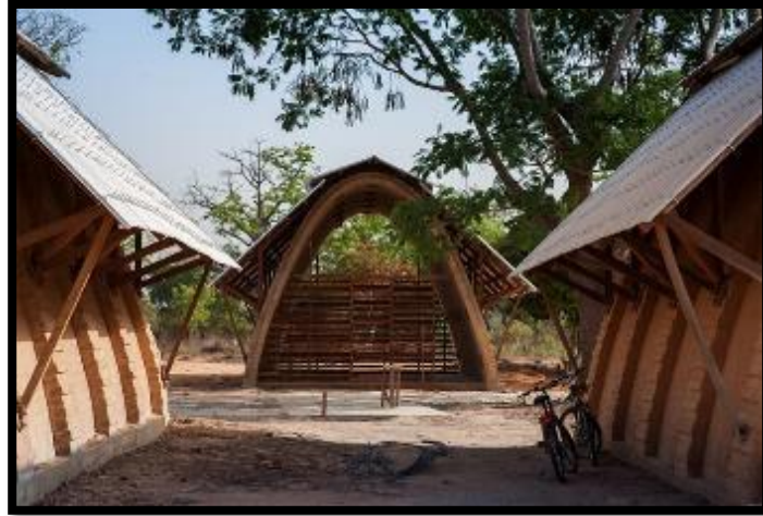
Figura 33: Vista frontal de la bóveda catenaria "DAW OFFICE"
