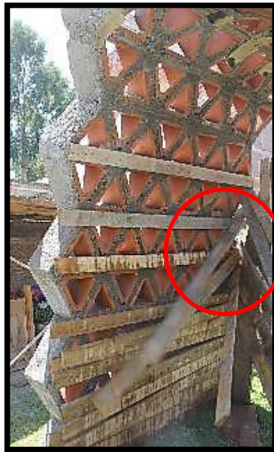
Fotografía 29: Desentablado del encofrado
