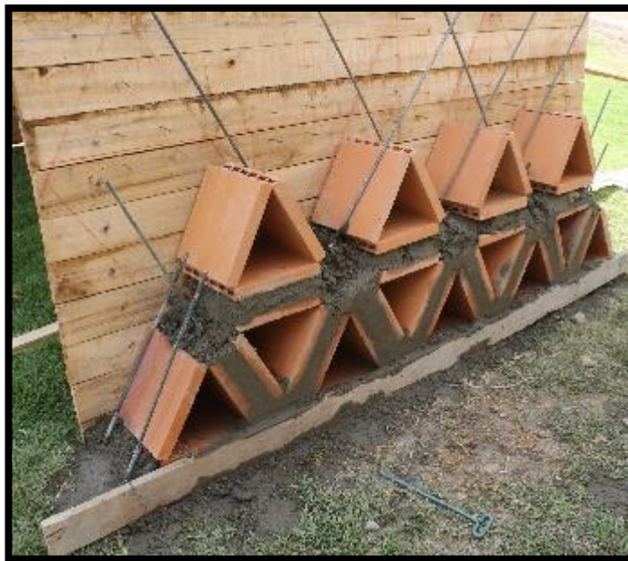
Fotografía 25: Asentado de módulos triangulares
