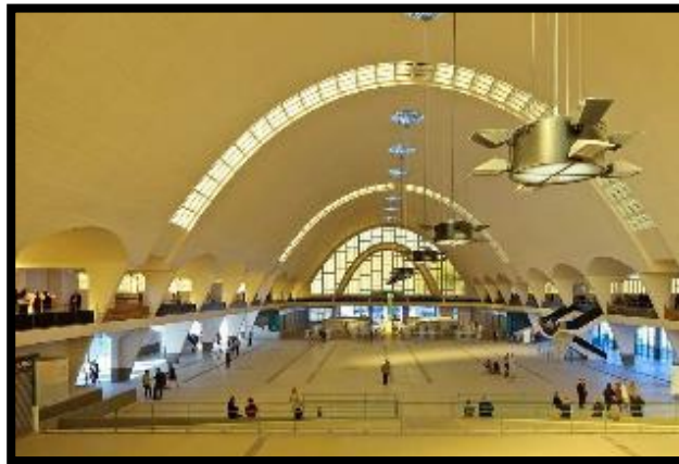
Figura 38: Vista interior del "MERCADO CENTRAL DE REIMS"
