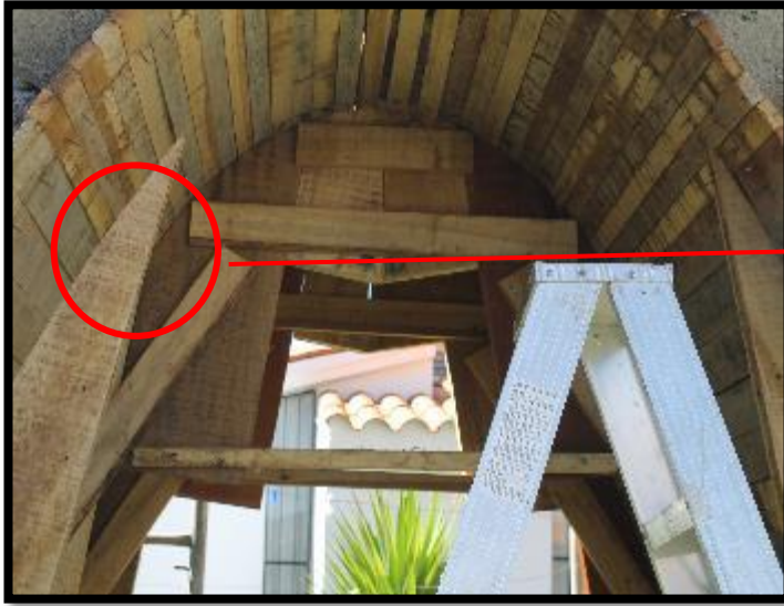
Fotografía 28: Desencofrado de bóveda catenaria
