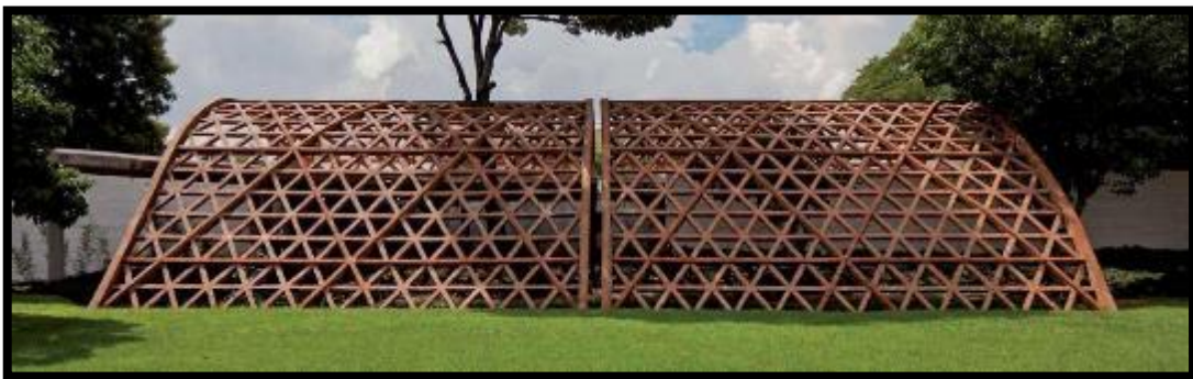
Figura 16: Vista frontal de bóveda exterior
