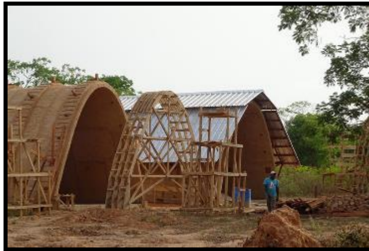
Figura 34: Cimbra de la bóveda catenaria "DAW OFFICE"
