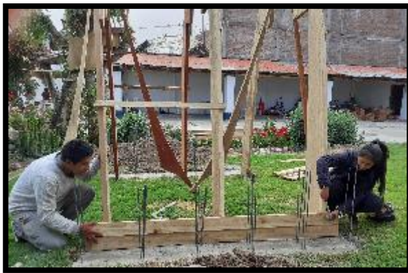
Fotografía 17: Entablado del encofrado
