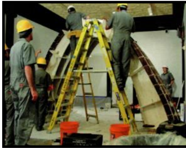
Figura 43: Vista de la elaboración de un prototipo de bóveda catenaria de ladrillo
