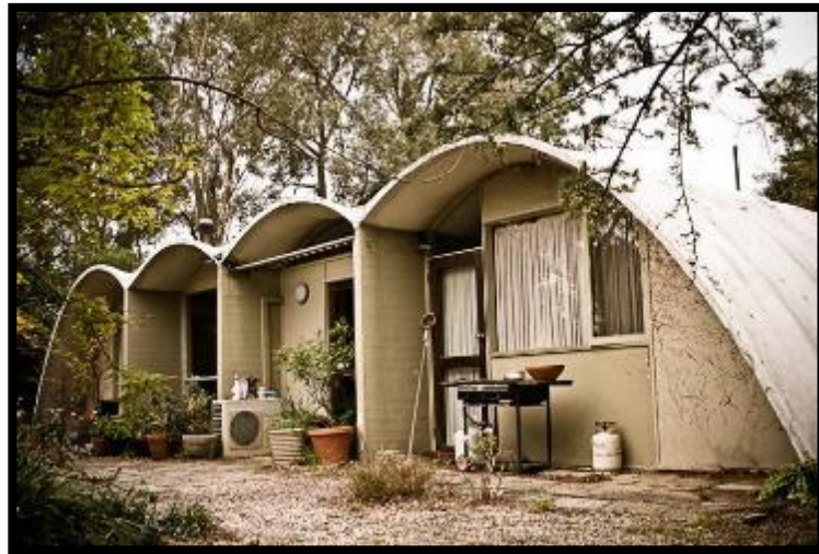
Figura 2: Vista exterior de rice house
