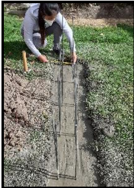
Fotografía 11: Distribución de fierros de 8mm
