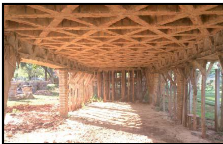
Figura 22: Vista interior "PASARELA DE LA UNIVERSIDAD NACIONAL DE ASUNCION"
