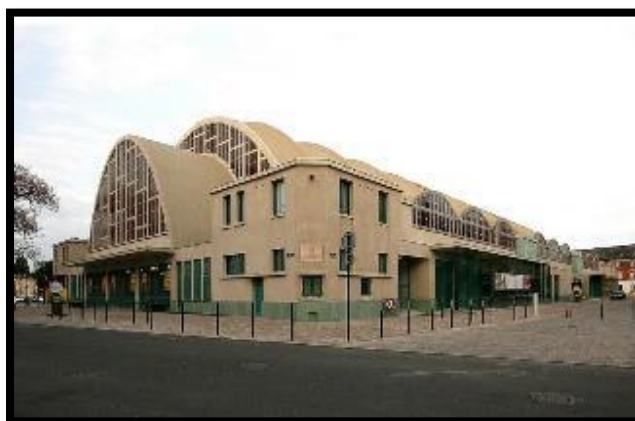
Figura 39: Vista exterior del "MERCADO CENTRAL DE REIMS"
