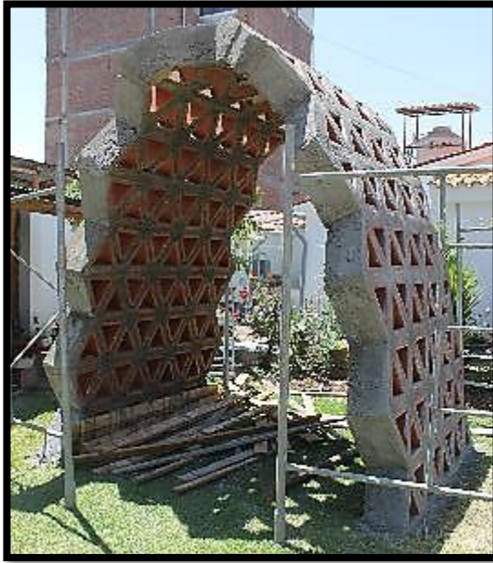
Fotografía 30: Vista de bóveda catenaria sin encofrado
