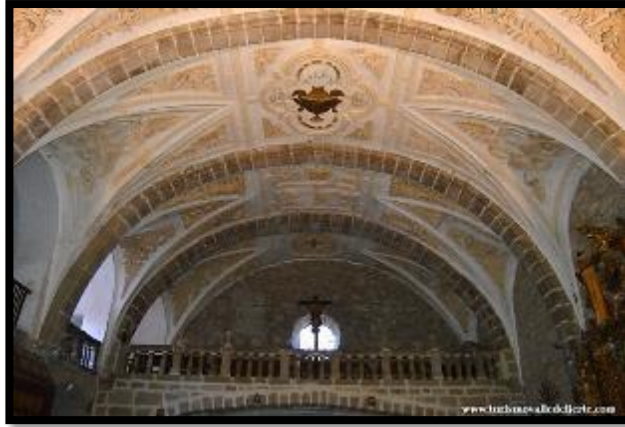
Figura 65: Bóveda apainelada
