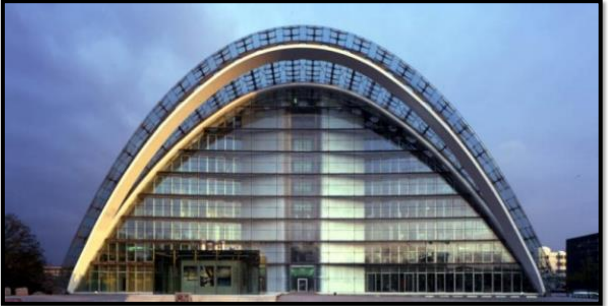
Figura 42: Vista Frontal del edificio Berliner Bogen
