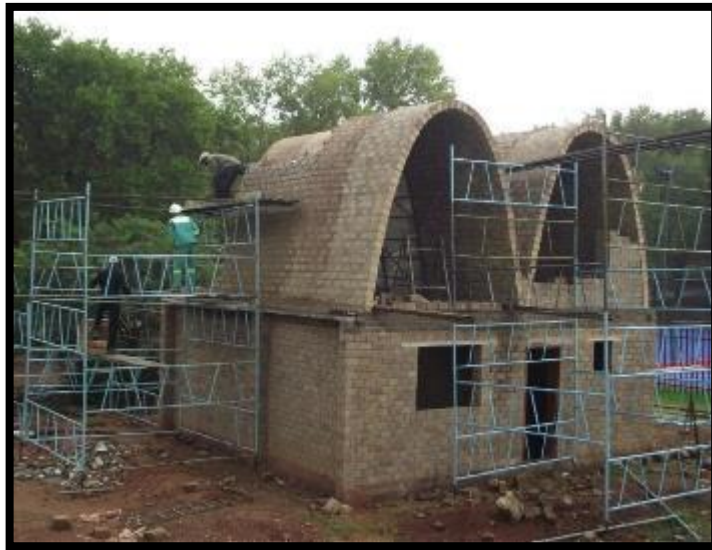
Figura 20: Proceso constructivo de bóveda catenaria
