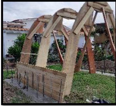
Fotografía 18: Entablado del encofrado
