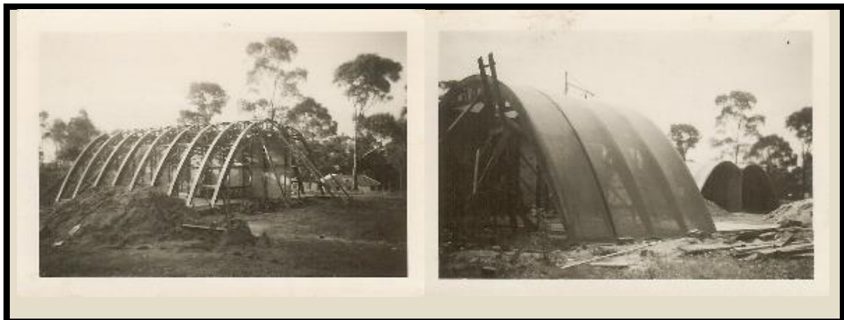
Figura 3: Proceso constructivo de arcos catenarios de madera cubiertos de arpillera
