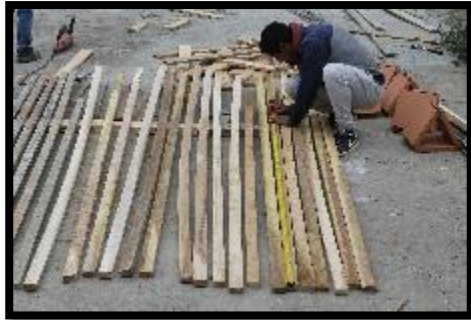
Fotografía 16: Medición de listones para la elaboración del encofrado
