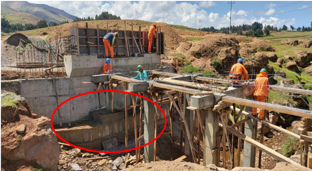
Imagen N° 03 Labores realizadas en escombros
