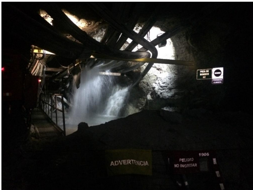
Cámara de bombeo 2 (nivel 535)
