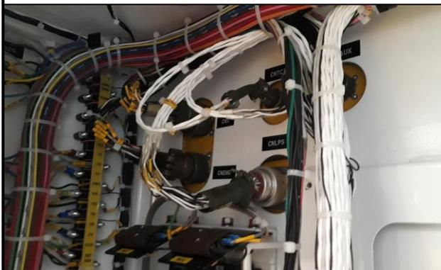
ii. Por el lado derecho, gran parte del arnés va por los soportes del medio y una parte por los soportes más externos, Uso de aislantes fijos y móviles dependiendo de grado de junta a realizar.
