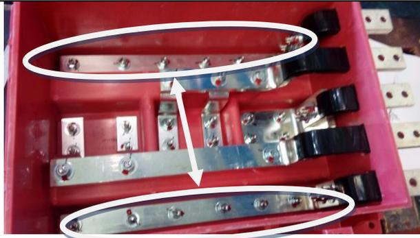
10. Ajustar los pernos de 5/16" – 18 UN X 3" con una llave de torque calibrada a un valor de 15 Lb/ft en forma alternada, seguir lo siguiente perno torqueado perno marcado. Así mismo dar un apriete de 25 Lb/ft a los pernos de 3/8"-18 NC X2".
