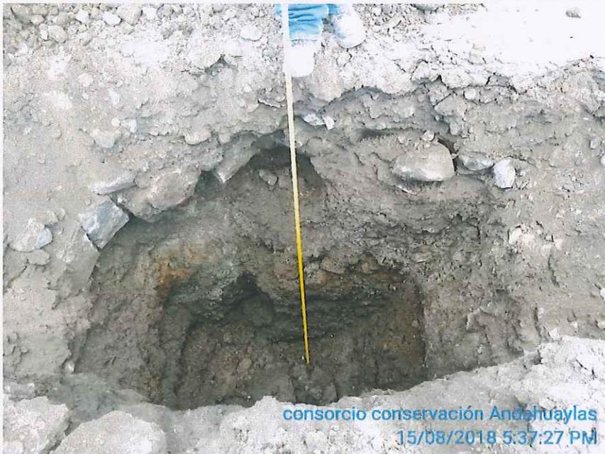
Figure 4 – por la calidad de los suelos, se observa que estos contienen gran contenido de humedad, los mismos que deben ser cambiados.
