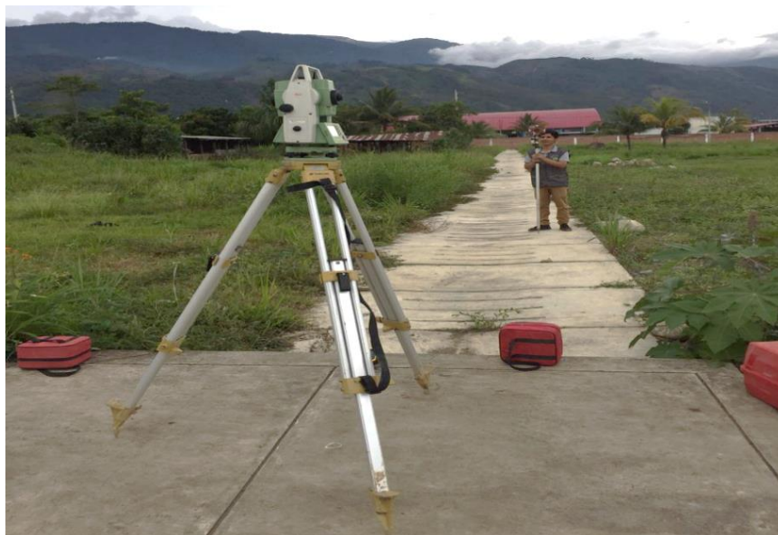
Imagen 18 Levantamiento topográfico con equipo estación total
