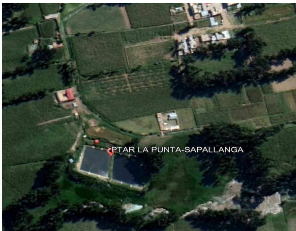
Figura 2. Planta de tratamiento de aguas residuales de La Punta- Sapallanga (11)
