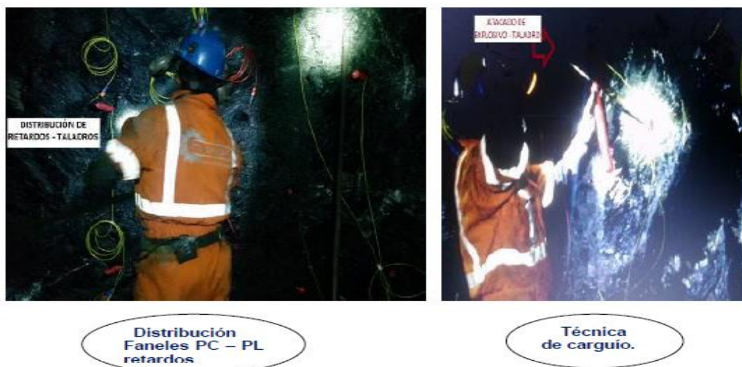
Figura 19. Técnica de carguío de taladros y distribución faneles – retardos
