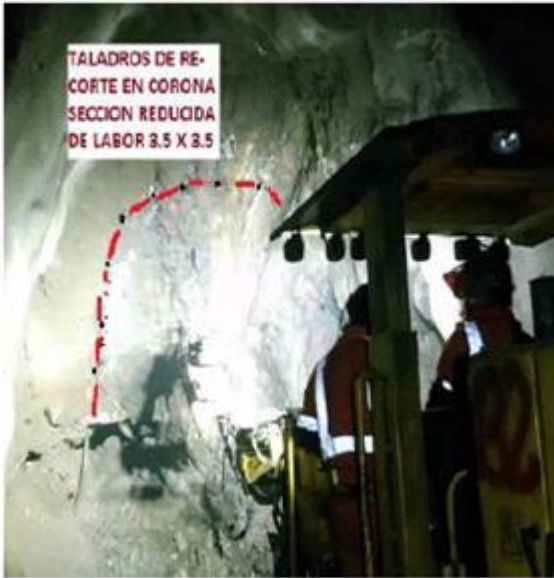
Implementación de Malla Perforación.
