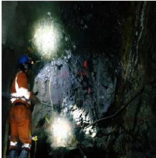
Carguío de explosivos
