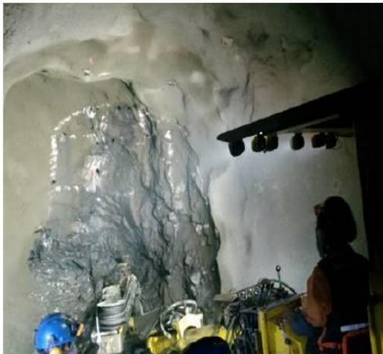
Figura 18. Capacitación en el campo sobre perforación, control de paralelismo y uso de guidores
