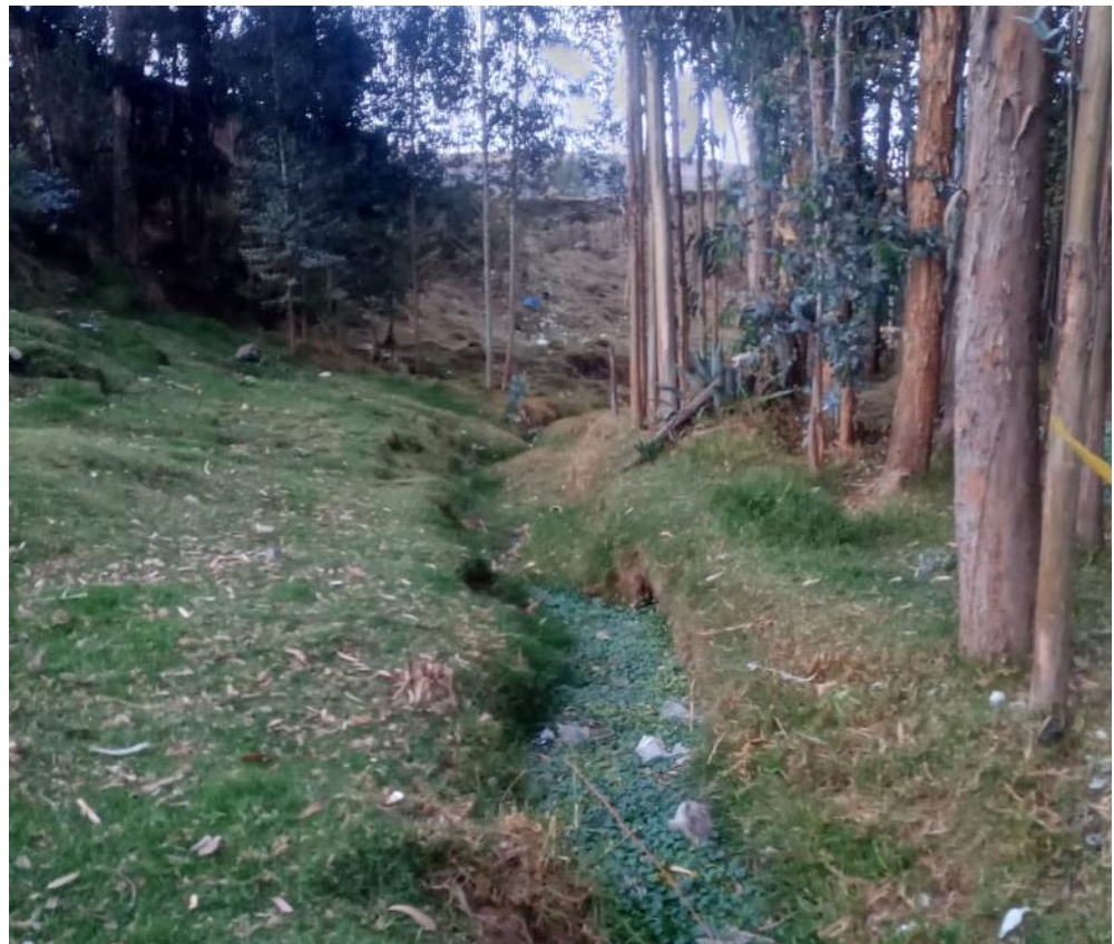
Fotografías 13 y 14. Paso de los canales de aguas residuales por zonas forestales.
