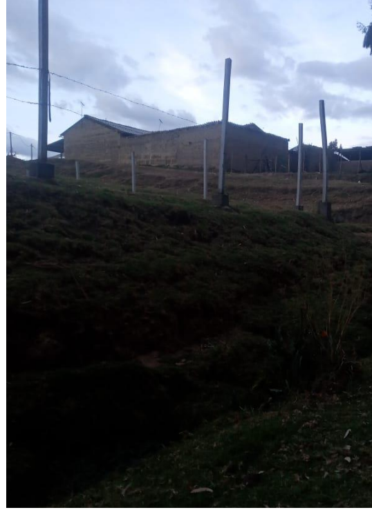
Fotografía 05 y 06. Cercos perimétricos incompletos de las pozas de estabilización de aguas residuales “San Pablo”.
