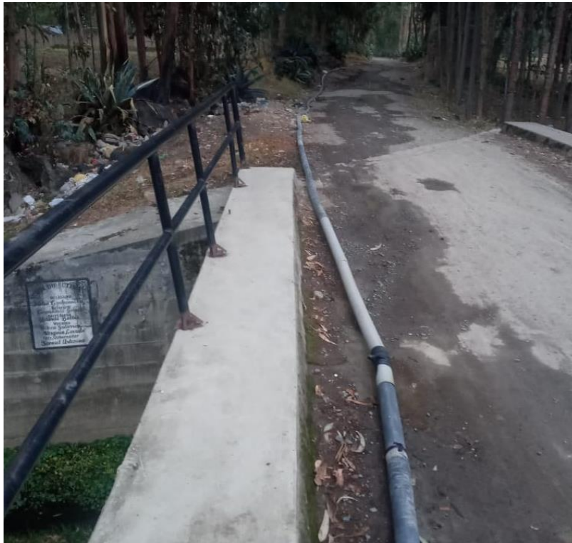
Fotografías 15 y 16. Tuberías que conducen aguas residuales para riego de terrenos agrícolas de la zona.
