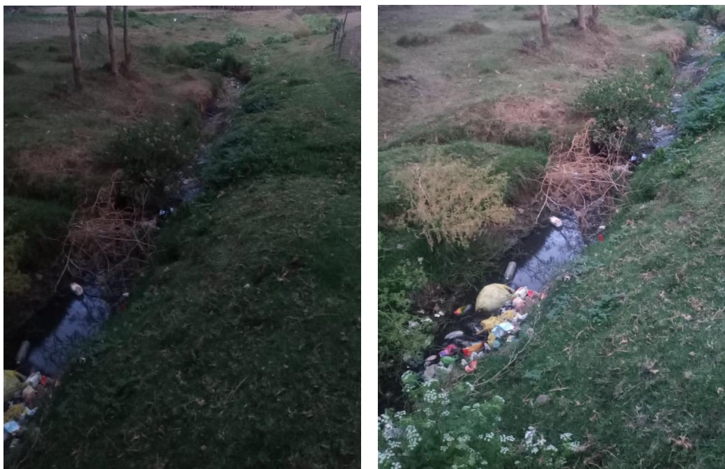
Fotografías 01 y 02. Ingreso de las aguas residuales del sistema de alcantarillado a las pozas de estabilización conducido por un canal descubierto.
