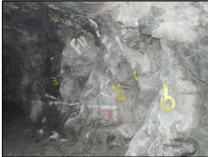
Figura 29. Fotografía de vista de los principales sistemas de fracturas en el cruceo XC-4375, mina Raúl
