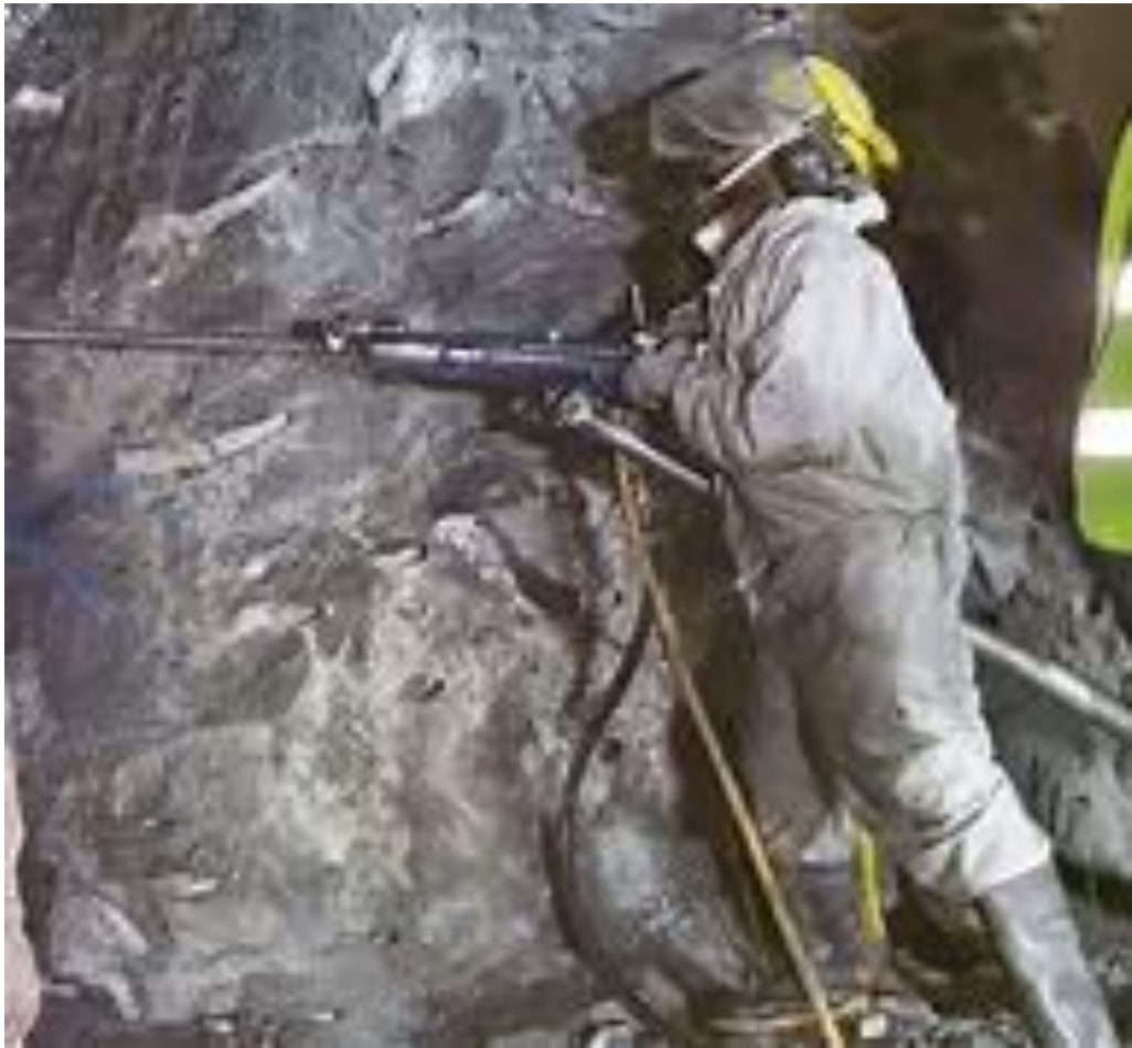
Figura 4. Realización de la perforación con máquina Jack Leg Tomado de compañía minera Century Mining Perú S.A.C, unidad minera San Juan de Chorunga
