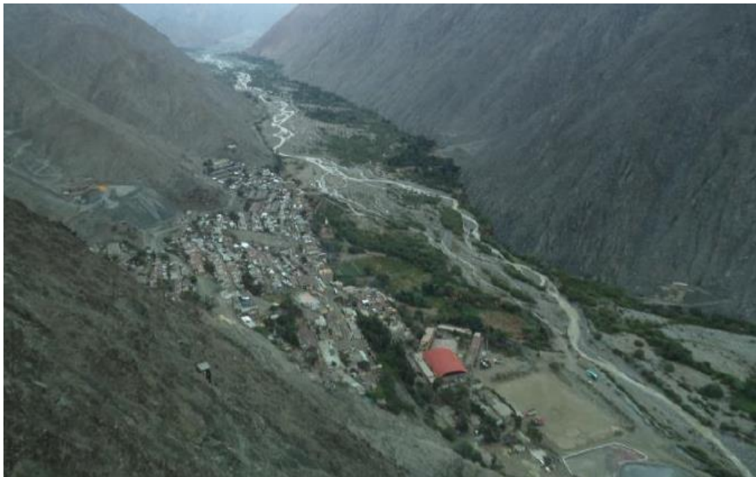
Figura 2. Campamento minero San Juan de Chorunga, vista Sur Oeste- Nor Este Tomado de compañía minera Century Mining Perú S.A.C, unidad minera San Juan de Chorunga
