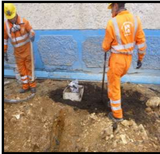
Figura 30. Instalación de componentes y caja registro
