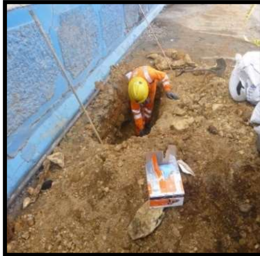
Figura 29. Ejecución y excavación de la poza a tierra
