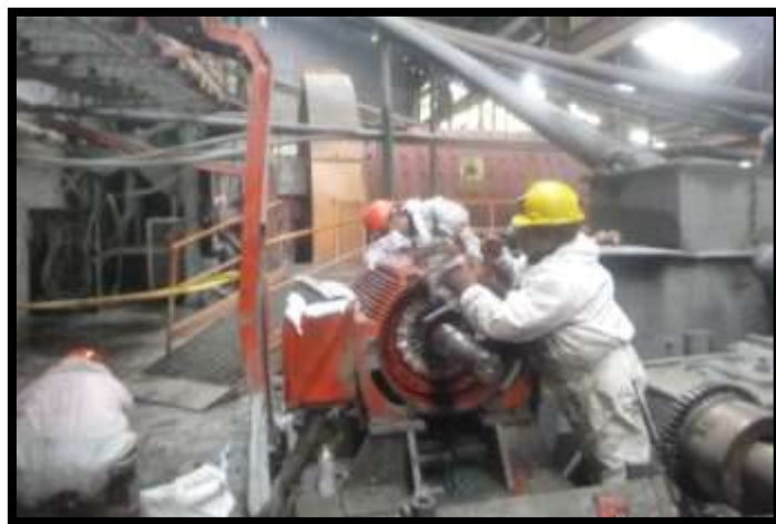
Figura 27. Mantenimiento preventivo a motor eléctrico de 250 HP
