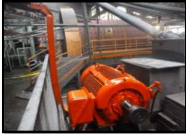
Figura 28. Montaje de motor de 250 HP para su acoplamiento
