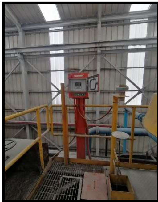
Figura 34. Tablero y sensor para el control automático de nivel
