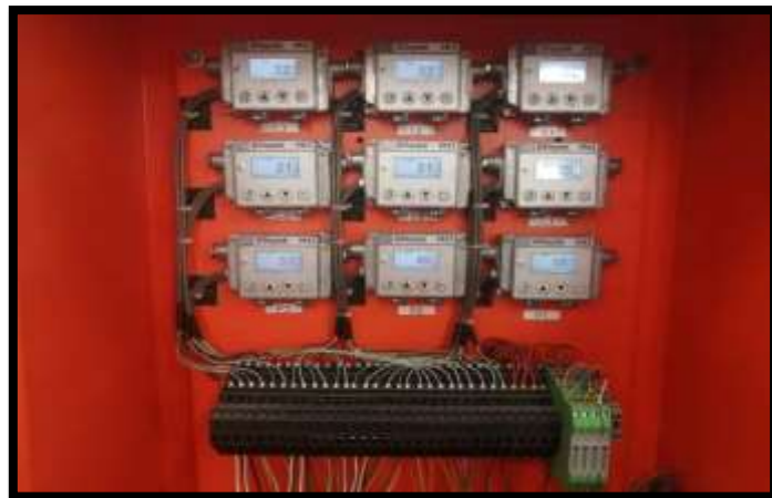
Figura 38. Tablero de control de sensores de vibración y temperatura de molino
