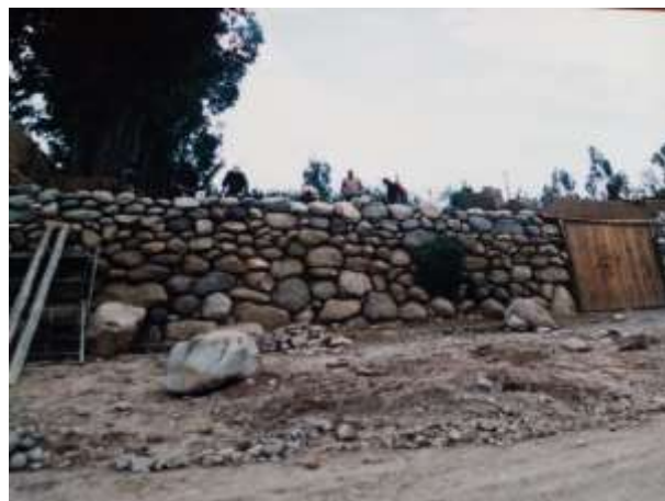
Figura 75: Construcción del muro de la fachada del museo
