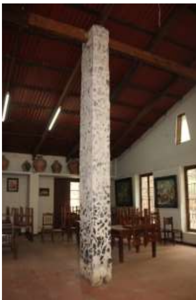
Figura 89: Textura de piedra laja negra y mortero de yeso
