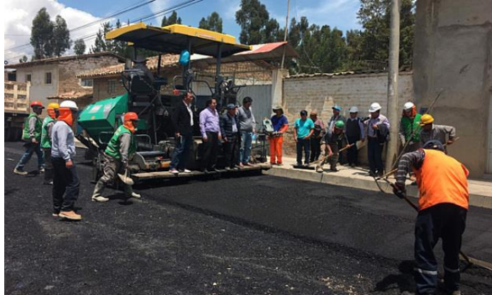
Figura 1: Trabajos para la constitución de la carpeta asfáltica en Huancayo.
