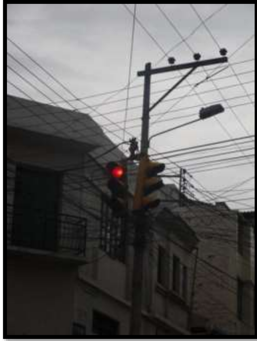
Figura 8. Impacto paisajístico causado por el alimentador en distribución aérea (5)
