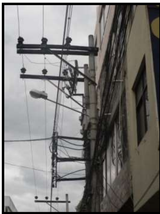
Figura 7. Impacto paisajístico causado por el alimentador en distribución aérea (14)
