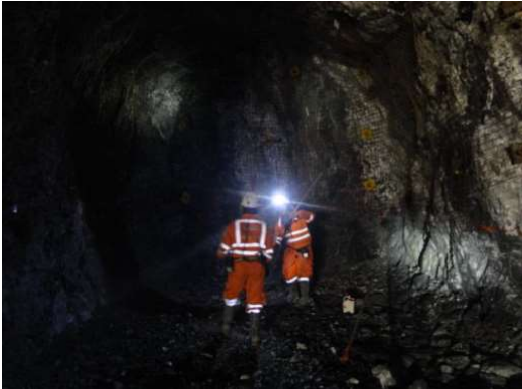
Figura 18. Vista del crucero 406, después de la voladura
