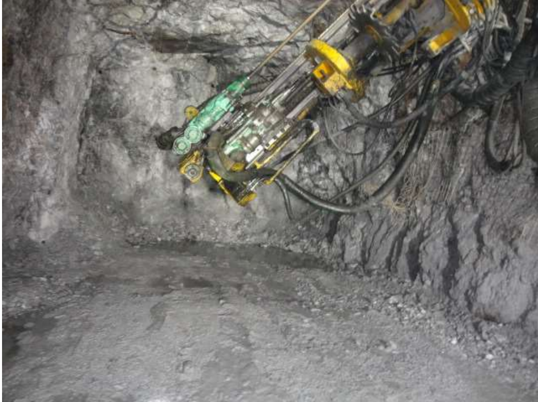
Figura 8. Vista de la rampa 446 después de la voladura
