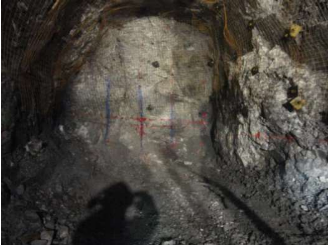
Figura 10. Vista de la rampa 446, después de la voladura
