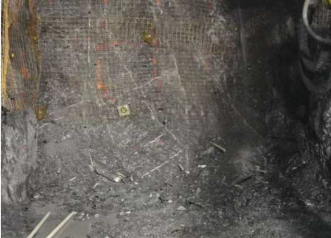
Figura 17. Vista del crucero 406, instalación de 5 tuberías en los taladros de arrastre
