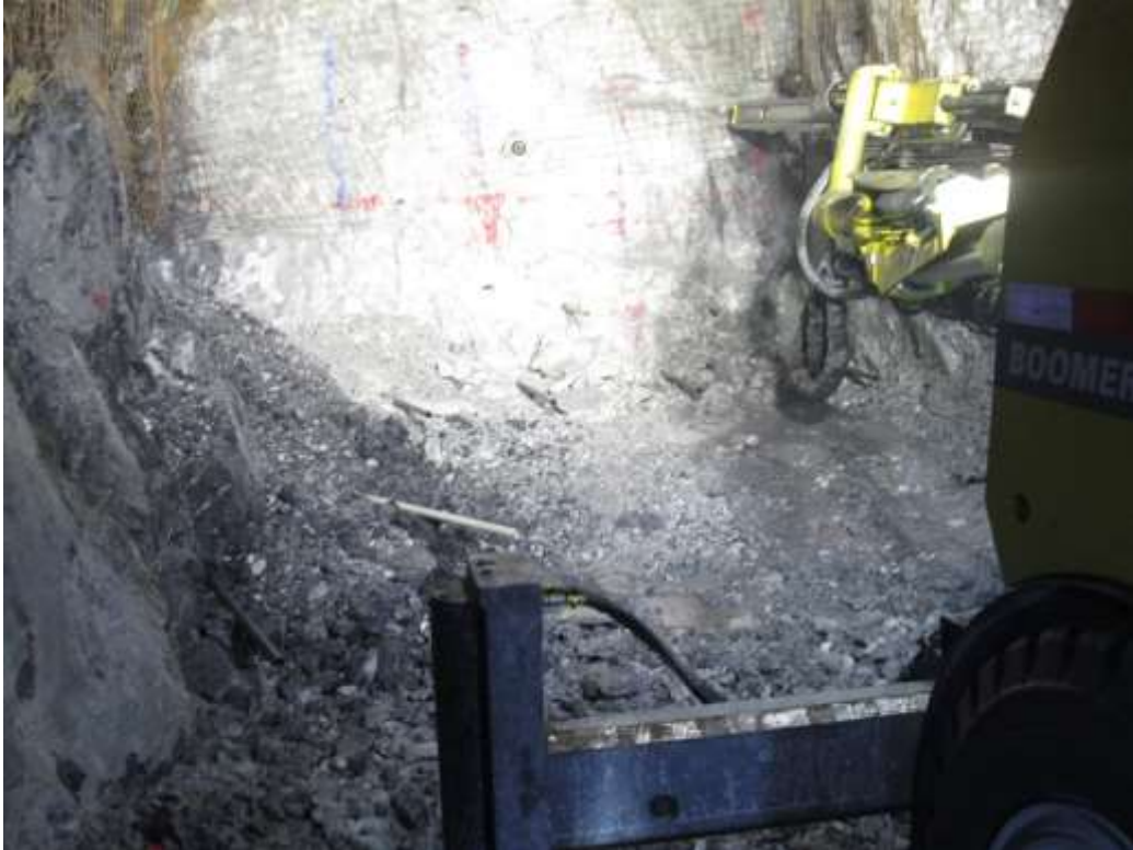
Figura 11. Vista de la rampa 446, instalación de 5 tuberías en los taladros de arrastre y 2 en las ayudas de los arrastres
