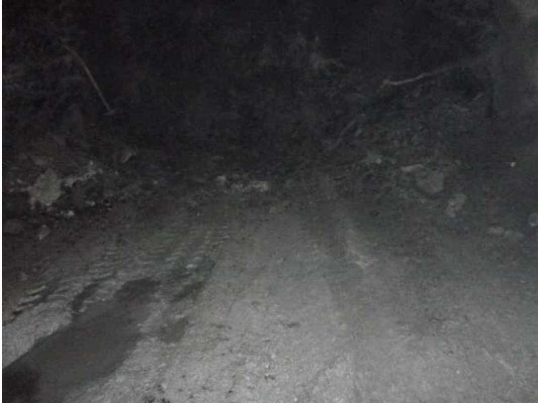
Figura 12. Vista de la rampa 446, después de la voladura
