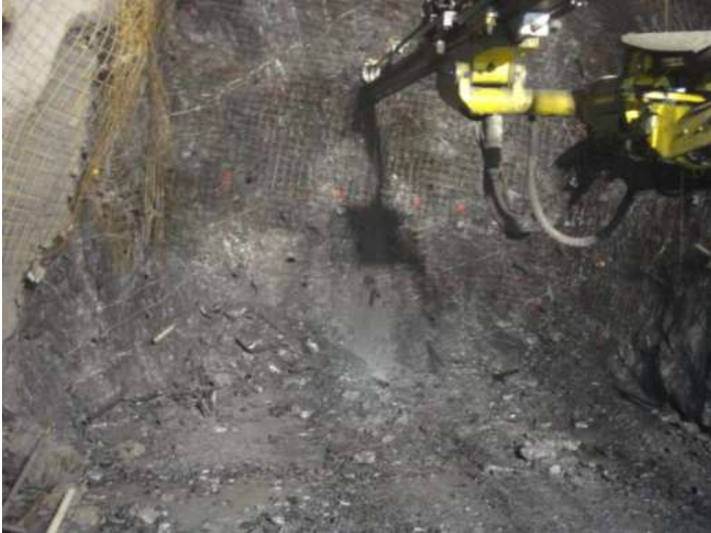
Figura 15. Vista del crucero 406, instalación de 5 tuberías en los taladros de arrastre
