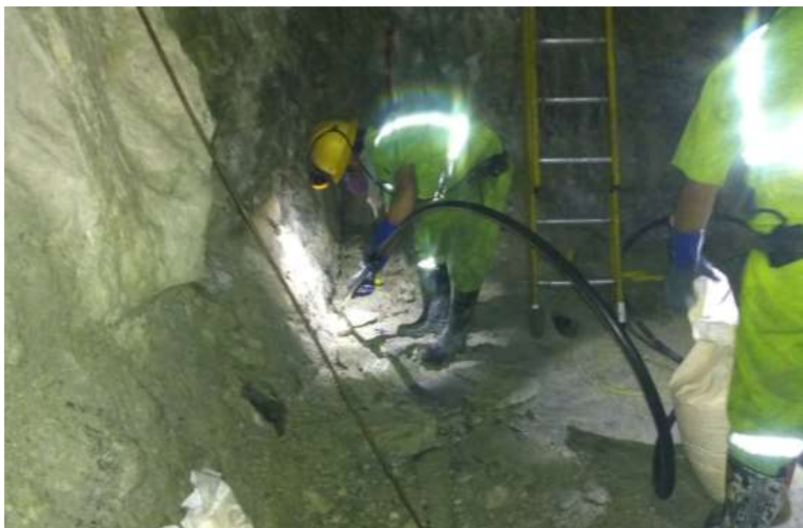
Figura 23. Carguío de tuberías herméticas
